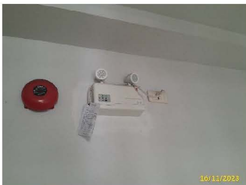
Battery ไฟฟ้าสำรอง
