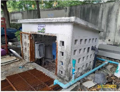
บ่อพร้อมปั๊มสูบน้ำทิ้งรตน้ำต้นไม้
